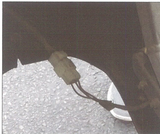
Gambar 10. Penggunaan konektor yang tidak kedap (Hermetically Sealed) pada engine kompartmen
