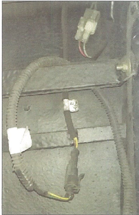
Gambar 12. Instalasi wiring tanpaudukan
