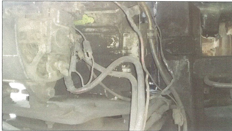
Gambar 11. Instalasi wiring dan conduit
