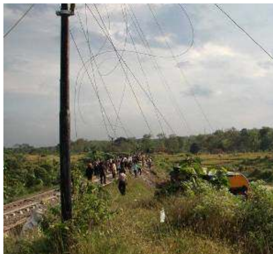
Gambar 4. Saluran komunikasi terputus akibat PLH
