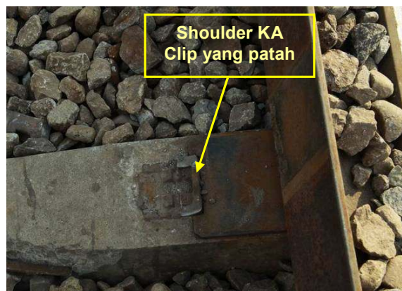
Gambar 12. Penambat KA Clip yang terlepas akibat PLH
