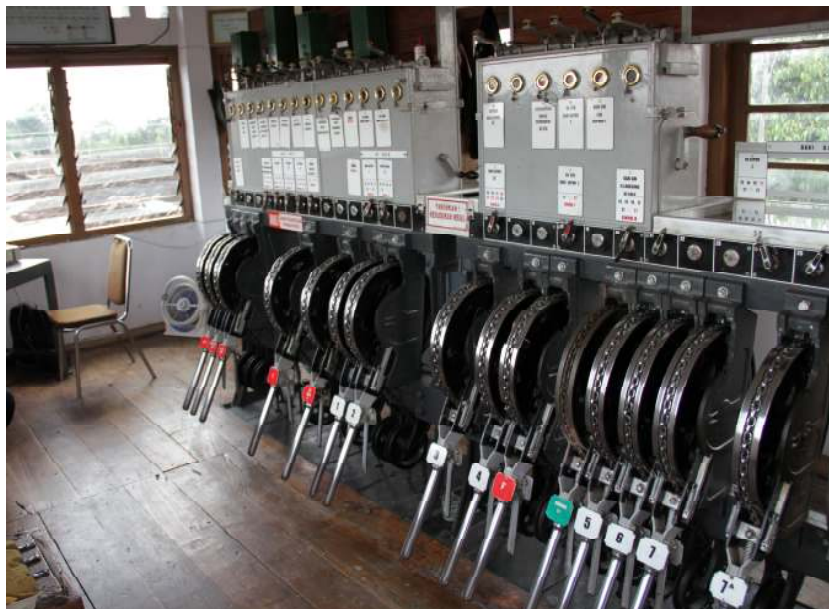
Gambar 7. Pesawat blok di Rumah Sinyal A St. Purwosari
