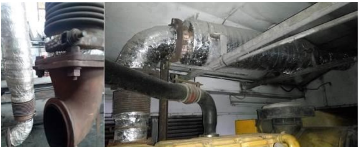
Gambar 18. Perlindungan Hot Surface Area
