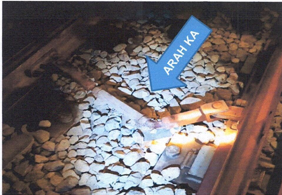
Gambar 2. Komponen connecting rod Wesel 11A dalam keadaan bengkok
