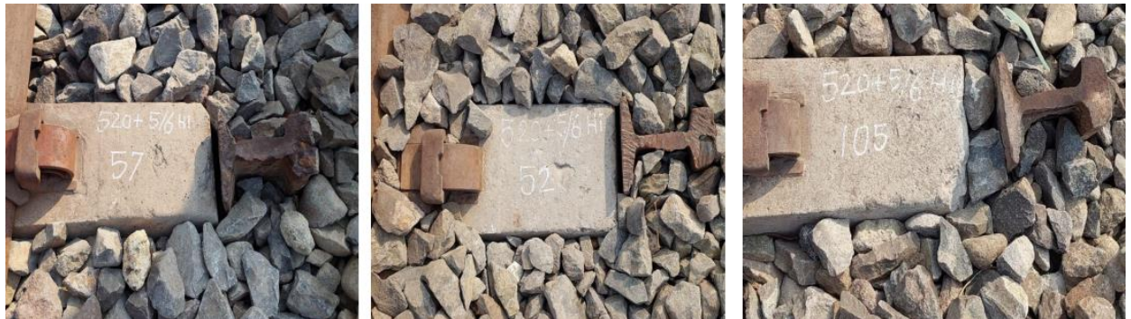
Gambar 9. Konstruksi potongan rel untuk menyangga bantalan
