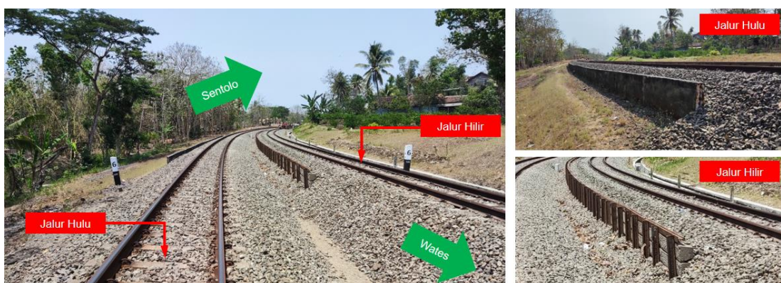
Gambar 6. Konstruksi penahan batu ballast di jalur hulu dan jalur hilir KM 520 + 5/6, petak jalan antara Stasiun Sentolo – Stasiun Wates
