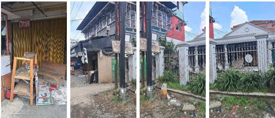
Gambar 12. Kondisi bangunan rusak di sekitar lokasi pasca ledakan
