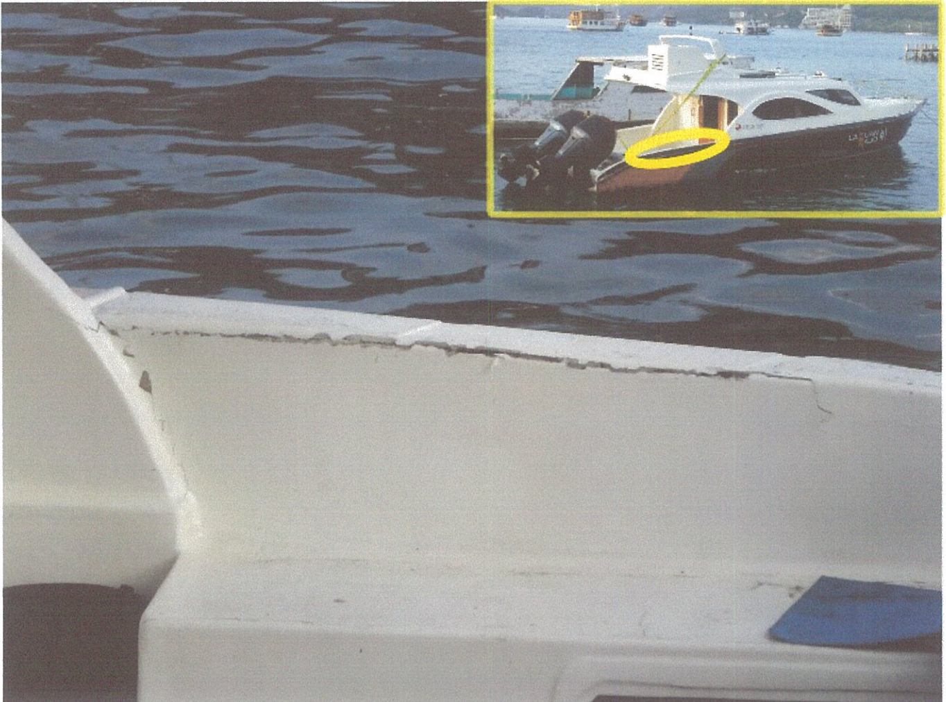
Gambar 2: Kerusakan pada dinding kanan buritan
