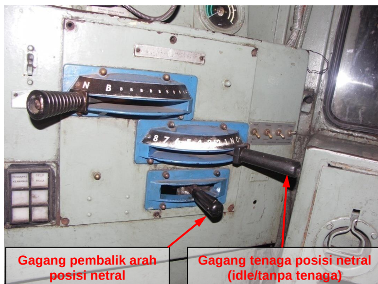
Gambar 7. Posisi gagang tenaga dan gagang pembalik arah pada kabin masinis KA 3516A
